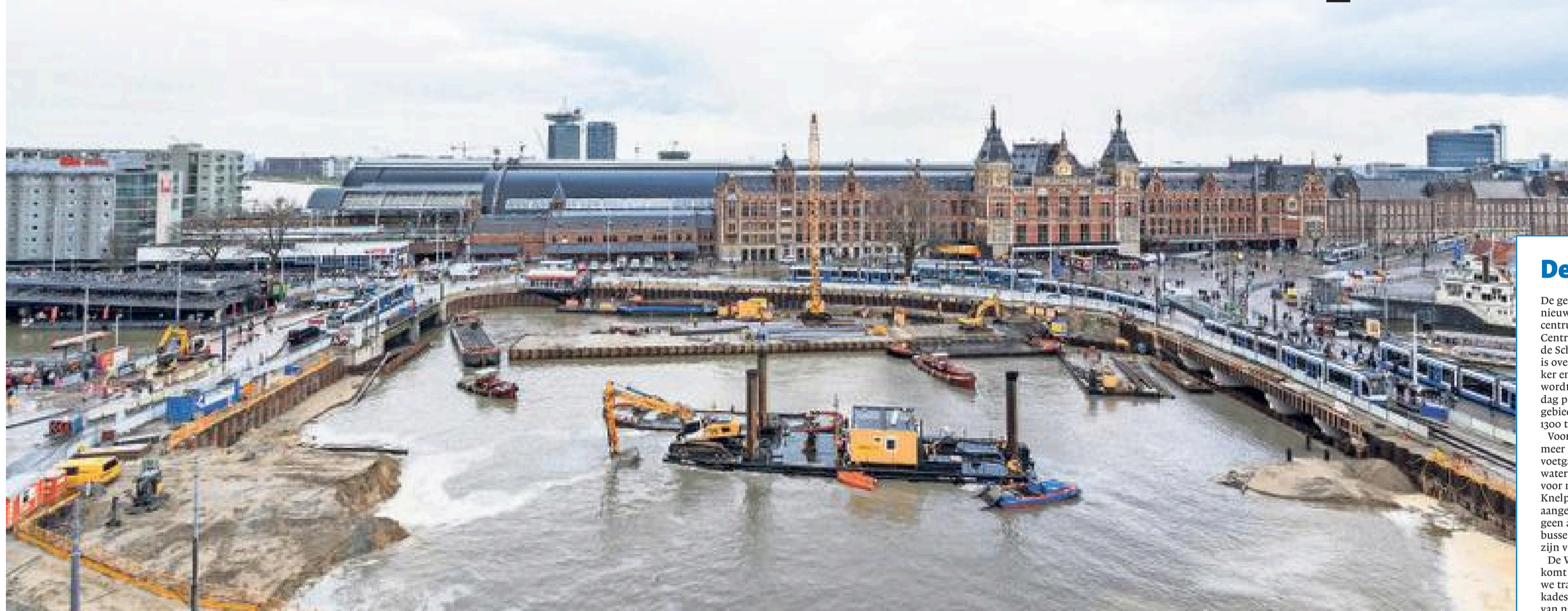
De bouwput voor het Centraal Station. In het midden het ponton met slaapaccommodatie. FOTO'S RAYMOND SCHINDELER/CONCRETE BOUW FOTOGRAFIE
